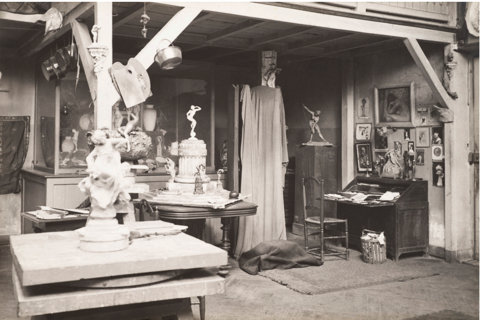
Côté sud-ouest de l'atelier du 89, boulevard Murat à Paris, octobre 1935, par Eugène Rudier ?, collection musée Jules-Desbois
